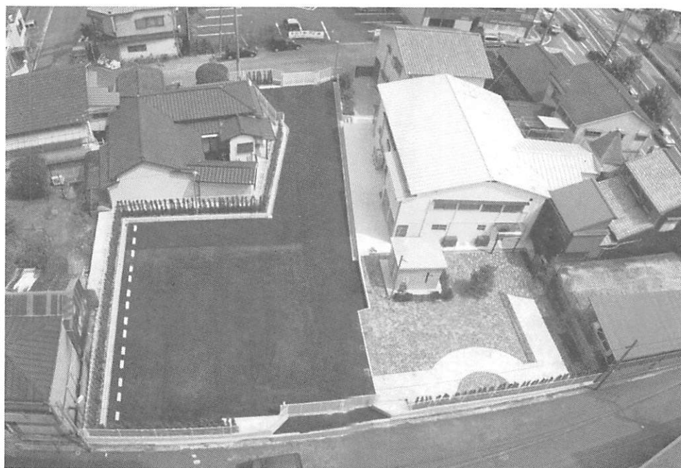
完成された新しい境内地
