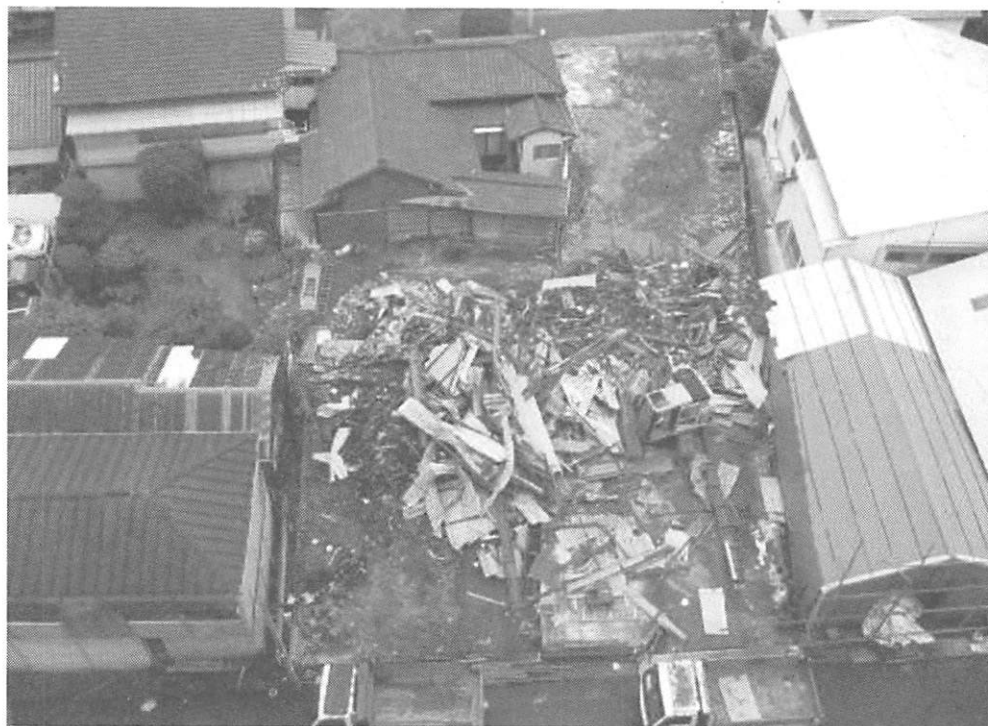
半分ほど解体が進む
